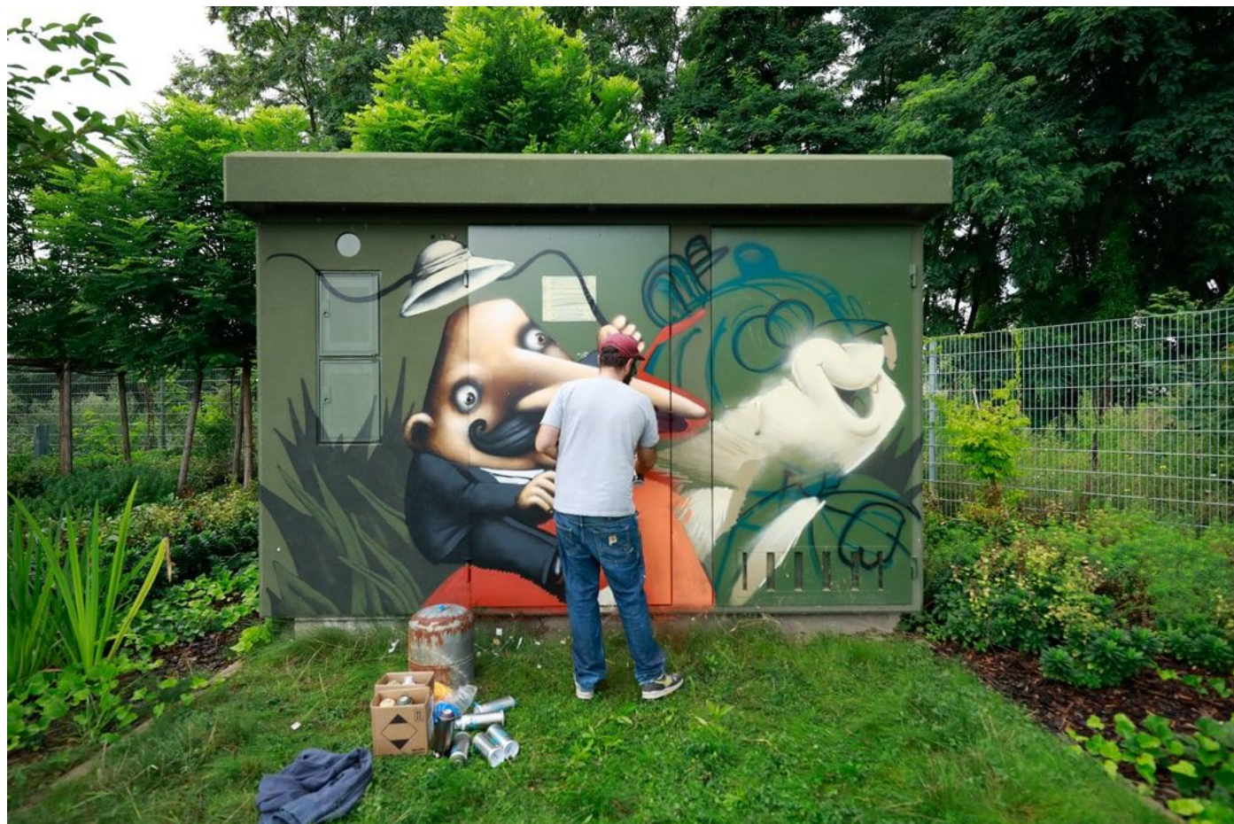
Mise en valeur d'un poste de transformation à Strasbourg
